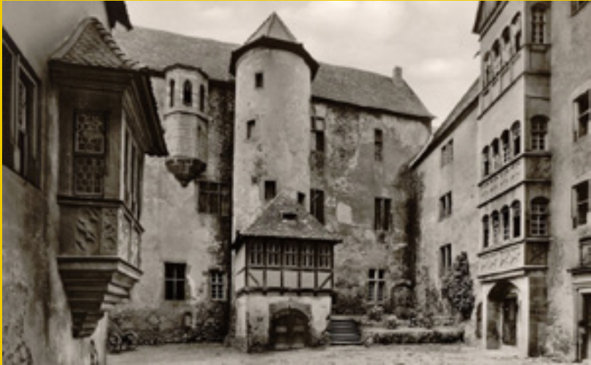
Ronneburg, Blick in den inneren Burghof
